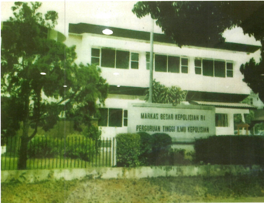
Gambar 13: PTIK di Jalan Tirtayasa Raya No. 6 Kebayoran Baru Jakarta Selatan. (Sumber: dokumentasi PTIK)
